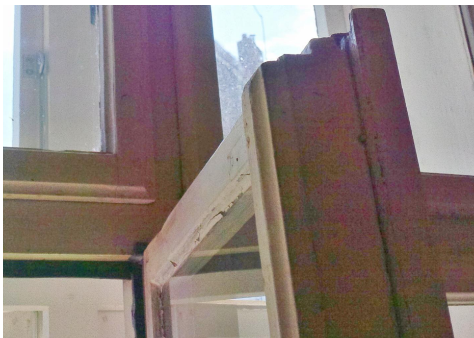
řezový pohled na profilaci okna
