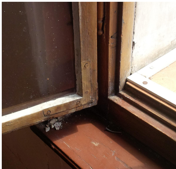
spojení křídla pomocí úhelníků
